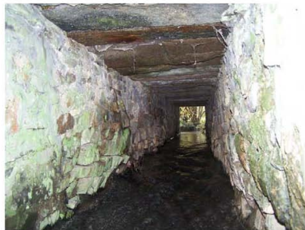
Intérieur de l'ouvrage
