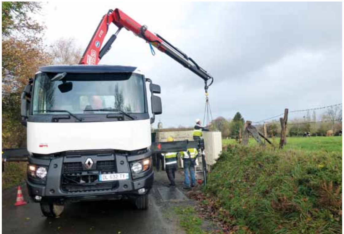
Après les dix premiers l'an passé, 62 sous-répartiteurs téléphoniques pourraient être fibrés cette année dans les campagnes ornaises.
