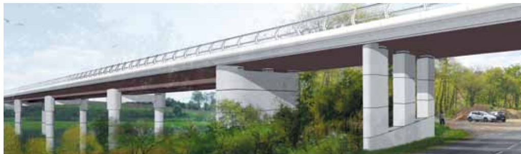
Le viaduc qui enjambera la Vère et la RD 300.
