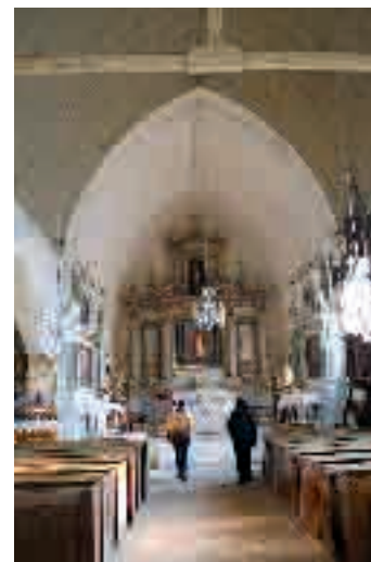
Le plafond de l'église, construit par des charpentiers marins.
