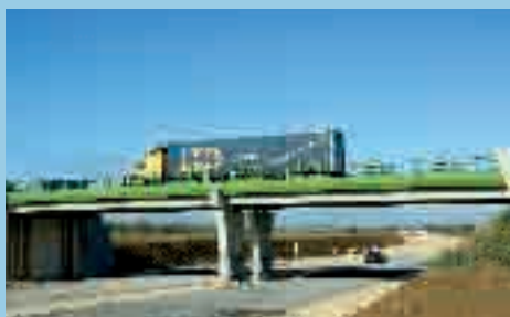
Alicorne, concessionnaire de l'A 88, a réalisé le giratoire de raccordement et le pont sur lequel la RD 924 franchit l'autoroute.
