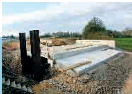
Le projet comprend la construction d'une trentaine d'ouvrages d'art.
