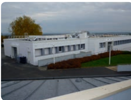
> Mortagne-au-Perche - Espace restauration isolé par l'extérieur au collège Émile Chartier
