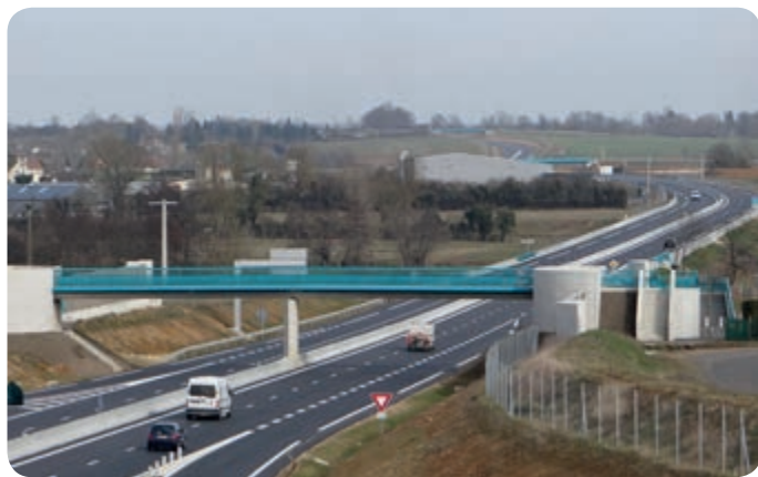
➤ Passerelle pour piétons à Sevrai
