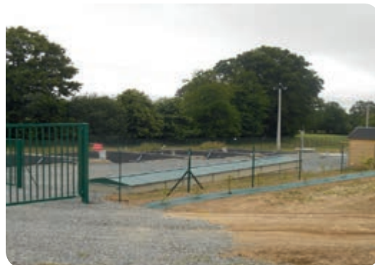
➤ Construction d'une nouvelle station d'épuration (400 Équivalent Habitant-EH) à Saint-Mars-d'Egrenne
