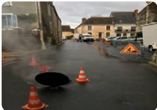
➤ Travaux de réhabilitation de réseau à Saint-Germain-de-la-Coudre
