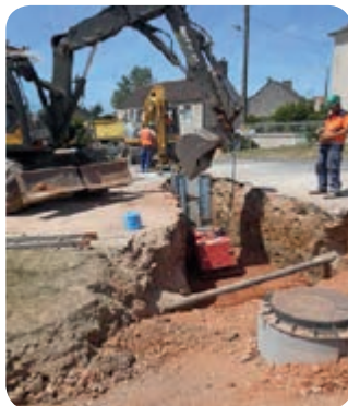
➤ Construction du réseau d'assainissement du bourg et de Pierrefite à Ronai
