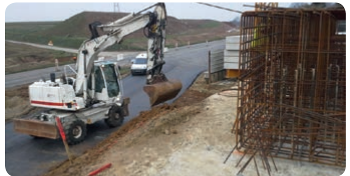
➤ Travaux RD 924 vers Durcet
