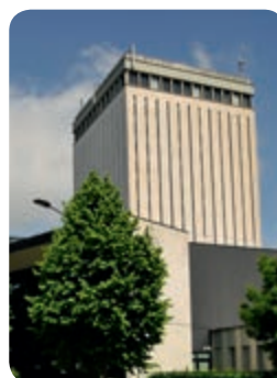
➤ Archives après travaux
