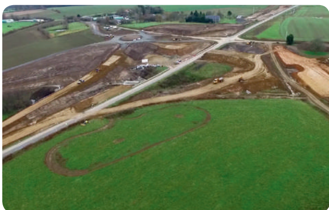
➤ RD 924 - L'échangeur du rocher en construction à Durcet
