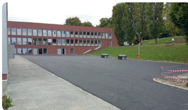
Le Theil-sur-Huisne Travaux de désamiantage et de réfection des sols au collège Yves-Montand
