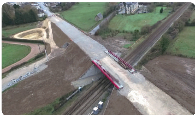
➤ Suppression des PN 104 et 105 à Nonant-le-Pin : le pont au-dessus des voies ferrées
