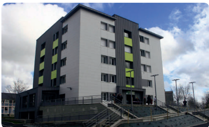
➤ Rénovation de l'immeuble abritant l'antenne d'action sociale de La Ferté-Macé
