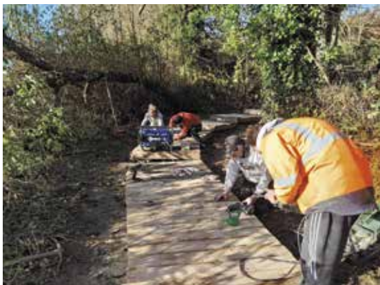
▲ Restauration du platelage en bois
